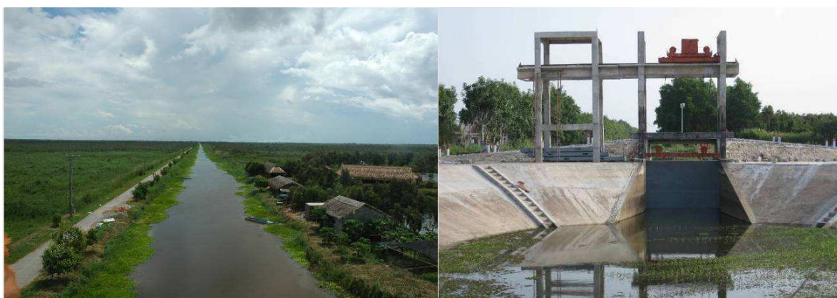
Hình 3.5. Hệ thống kênh và cống ở cống điều tiết nước ở VQG U Minh Thượng
