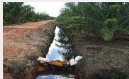
Gambar 2.8: Guludan yang digunakan untuk mencegah masuknya air ke lahan. Lahan yang terkena banjir juga akan menghambat semua operasi estate dan menambah emisi metana/nitrogen oksida. Kebakaran juga mengurangi hasil panen secara signifikan.
